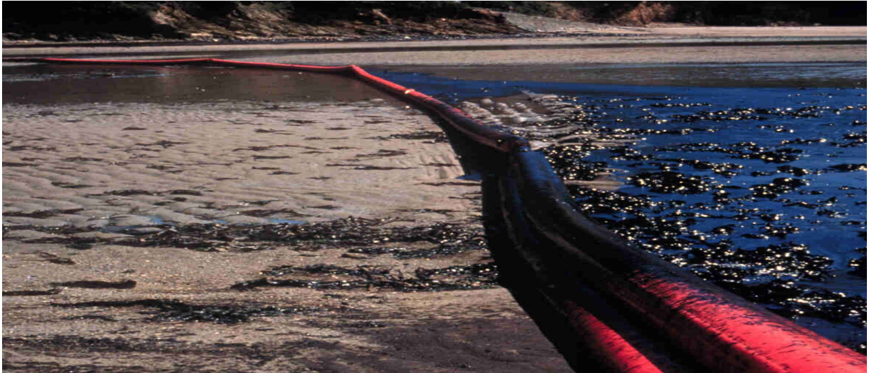
图 17 岸滩围油栏的布放方式一
