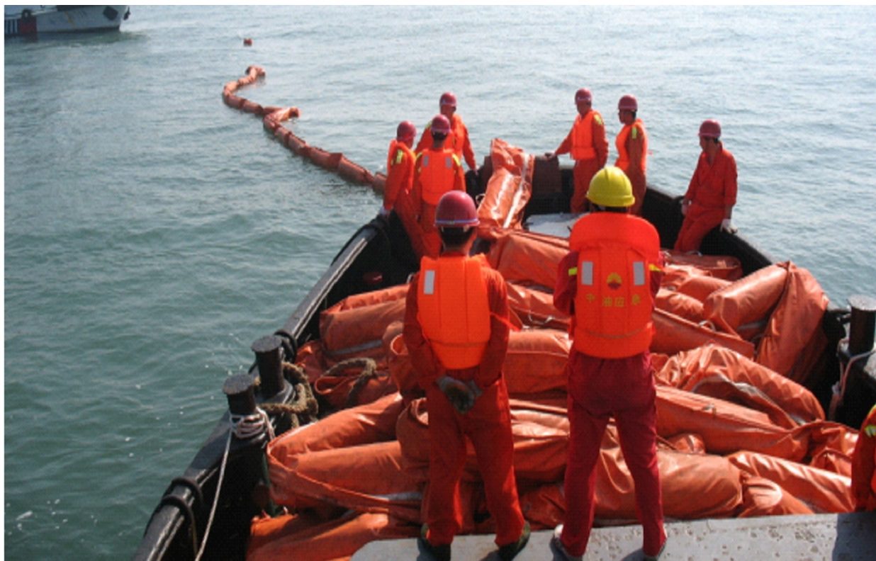
图 14 吸油拖栏的布放
