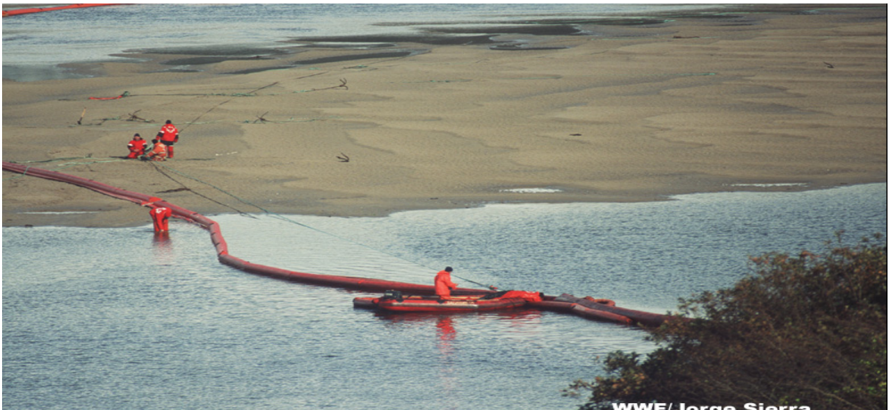
图 18 岸滩围油栏的布放方式二
